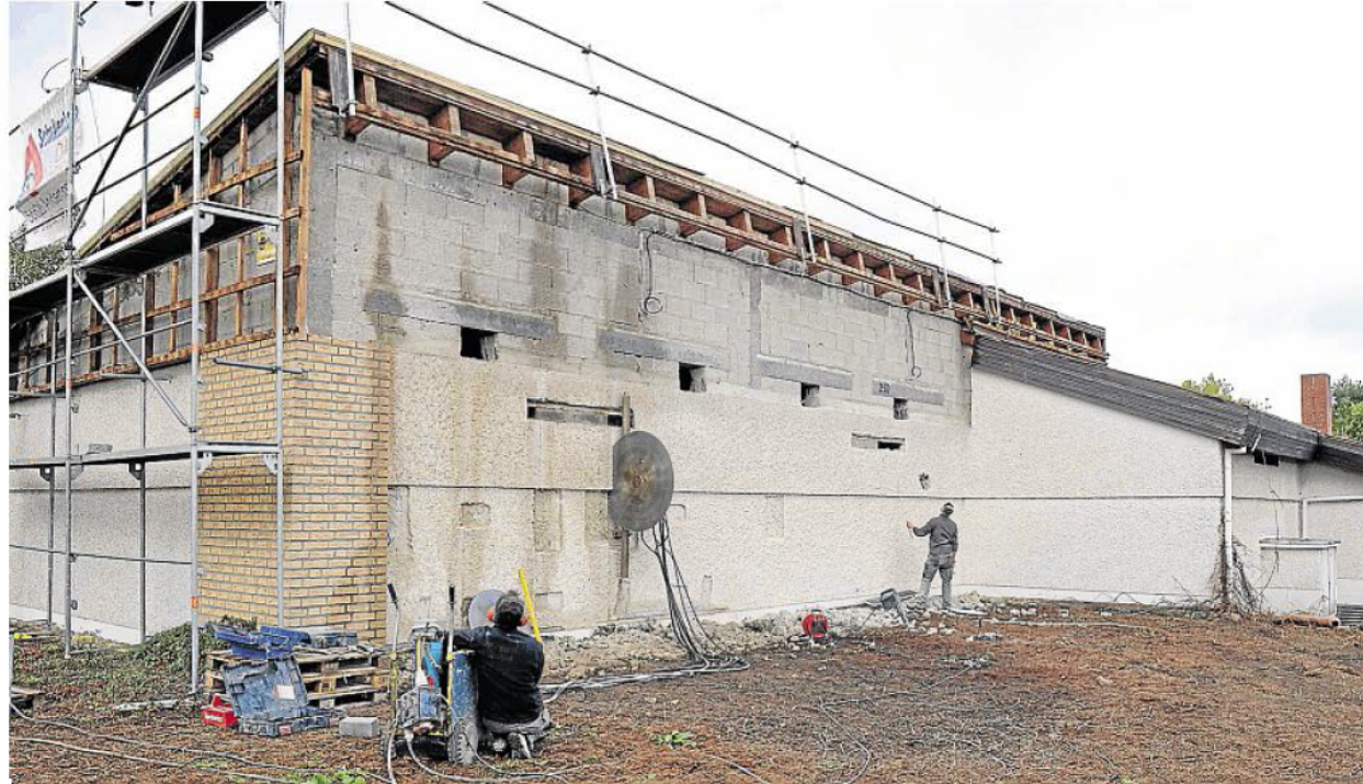
Noch ist das Sport- und Wellness-Zentrum eine Baustelle. Doch schon kommenden Februar soll die Einrichtung eröffnet werden.
